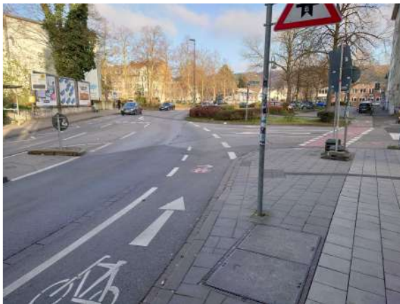
Abb. 7: Plötzliches Ende des Radstreifens auf dem Seffenter weg und nicht sinnvolle Rotmarkierung hinten rechts
