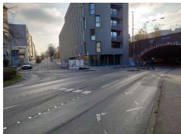
Abb. 10: Einmündung der Geschwister-Scholl-Straße auf den Seffenter Weg
