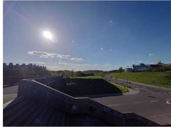
Abb. 28: Blick von der Brücke in Richtung Melaten mit Campus-Balkon rechts
