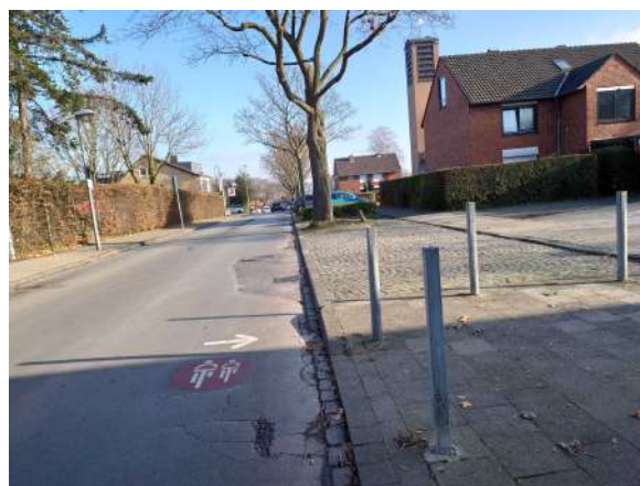
Abb. 21: Hohe Bordsteinkante an der Ahornstraße
